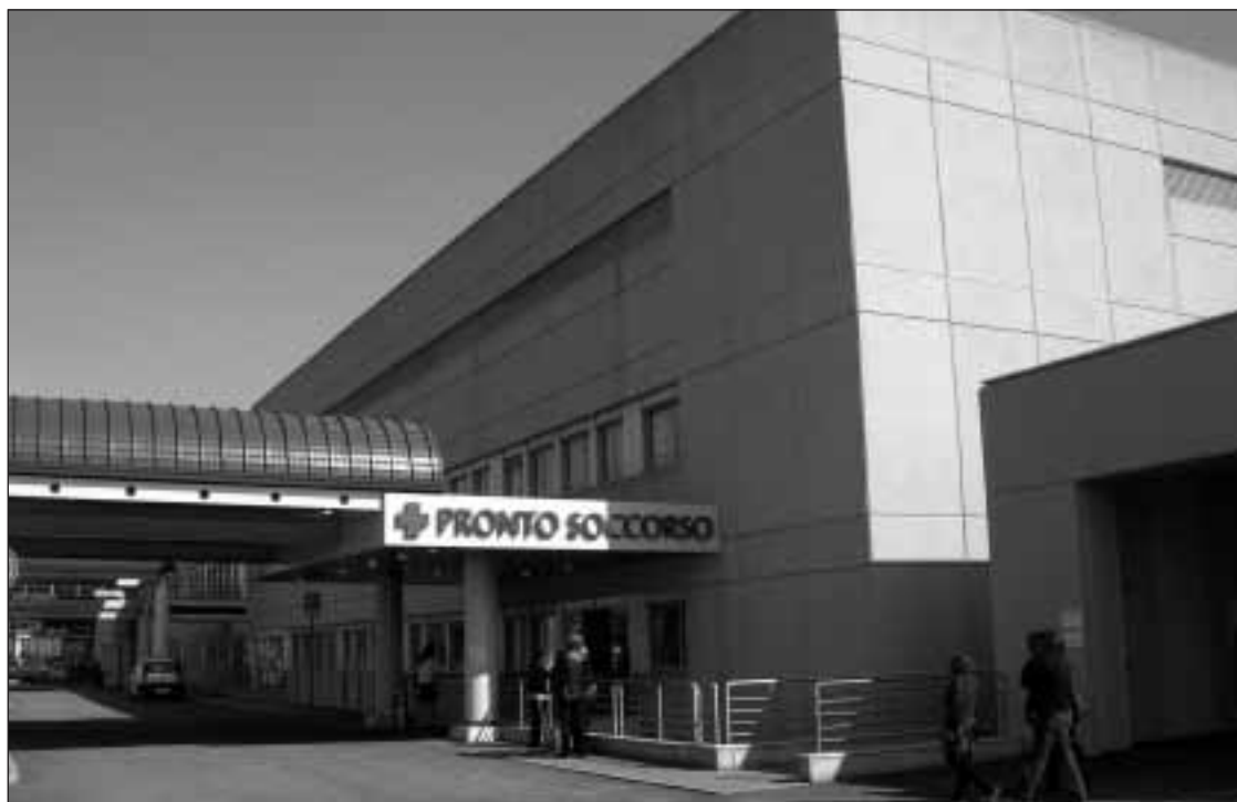
► Il pronto soccorso di Tor Vergata. Sotto uno dei macchinari non utilizzati
